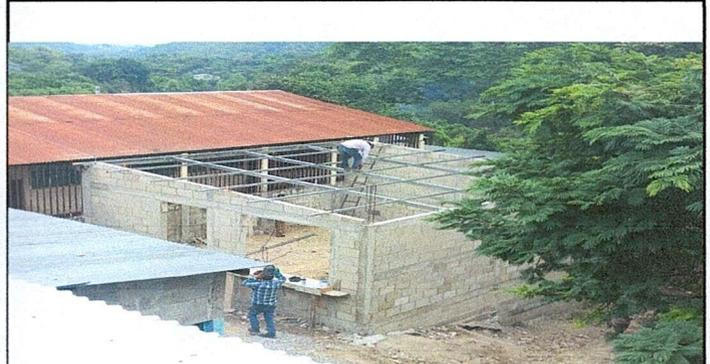
Foto 2: ÁREA DE LA PARTE DE ARRIBA DONDE SE ESTÁ REALIZANDO MEJORAMIENTO DE TECHO E INSTALACIÓN DE COSTANERAS.
